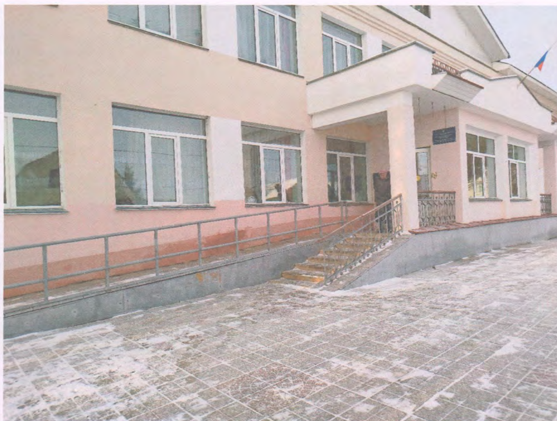
Вход в здание Фото № 6
